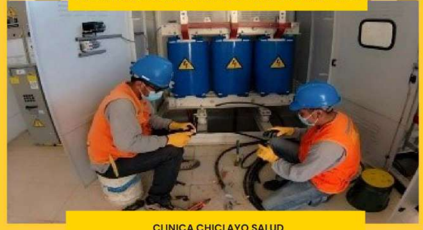
SISTEMA DE UTILIZACIÓN EN MEDIA TENSIÓN 22.9kV-10kV
