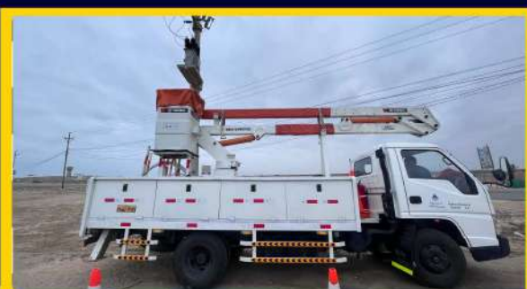
SERVICIO DE EMPALME EN LINEAS ENERGIZADAS 10KV
