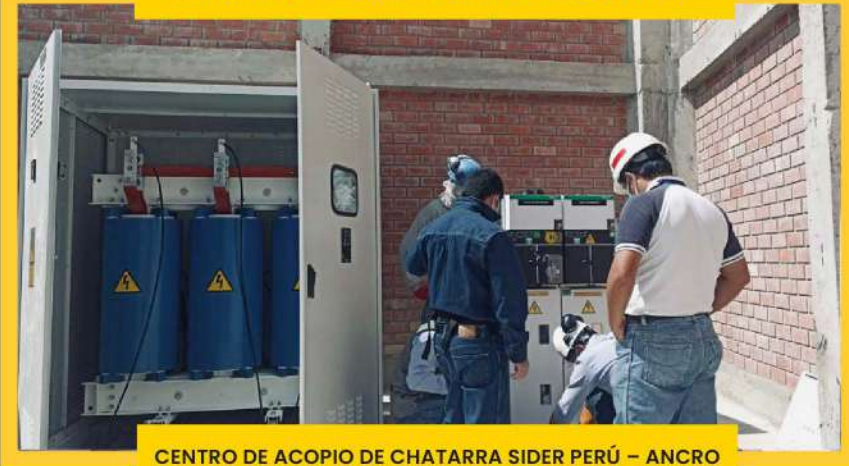
SISTEMA DE UTILIZACIÓN EN MEDIA TENSIÓN 22.9kV
