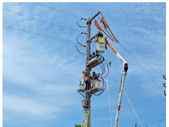
Servicio de empalme en líneas energizadas 10 KV
