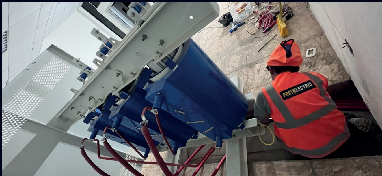
Instalación de transformador del tipo seco
