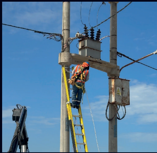
Mantenimiento de sistema Utilización 10KV
