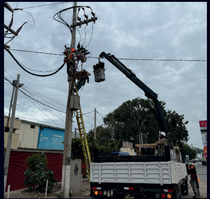
Montaje de Transformador
